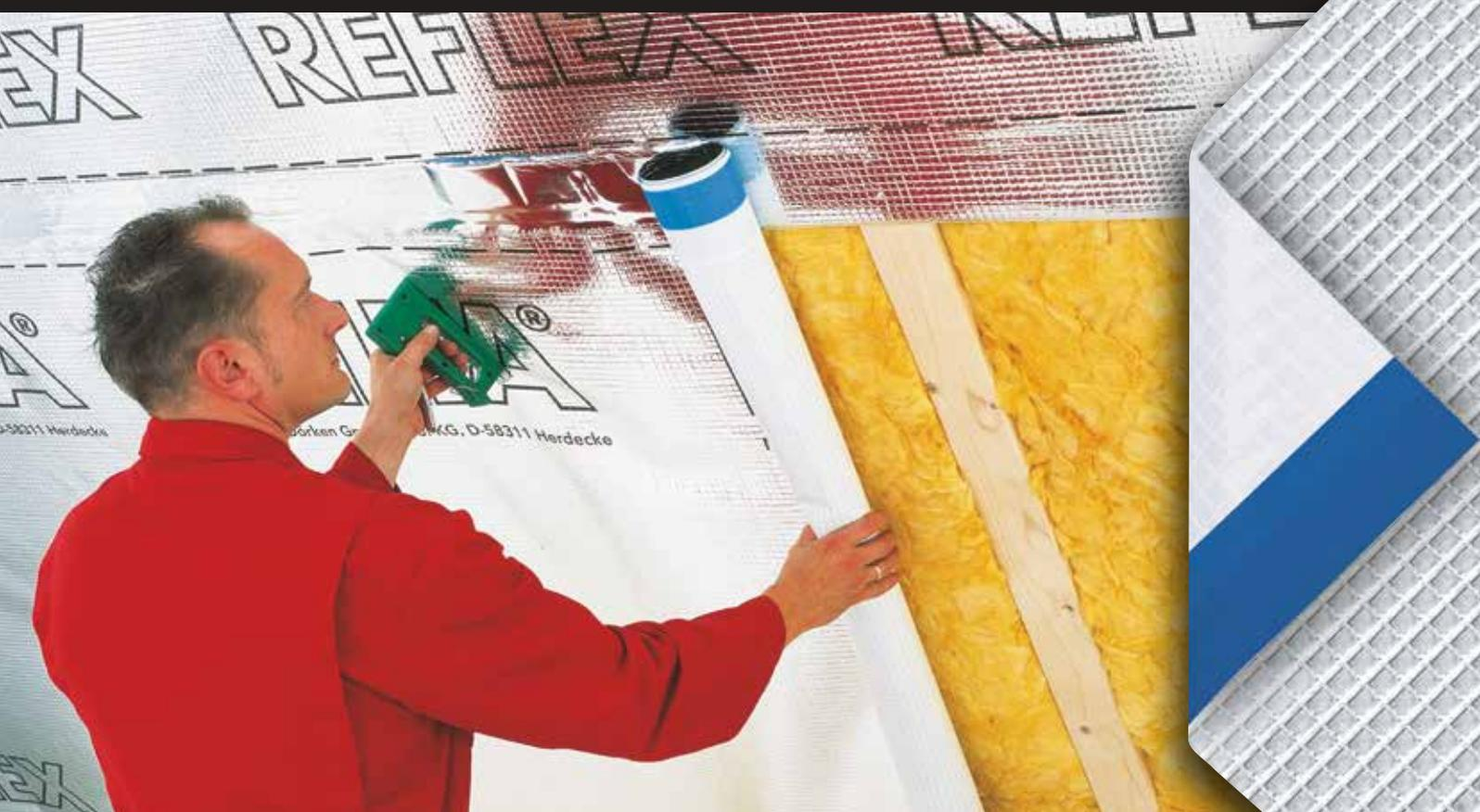
Армированная 4-слойная пароизоляционная плёнка для скатных и плоских крыш.
