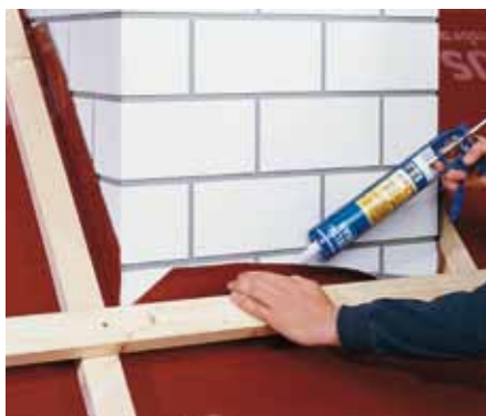
Примыкание к трубе с клеем DELTA®-THAN.
