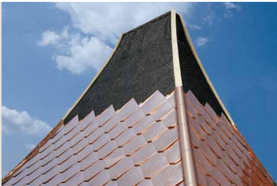
Объёмная мембрана DELTA®-TRELA для медной кровли.
