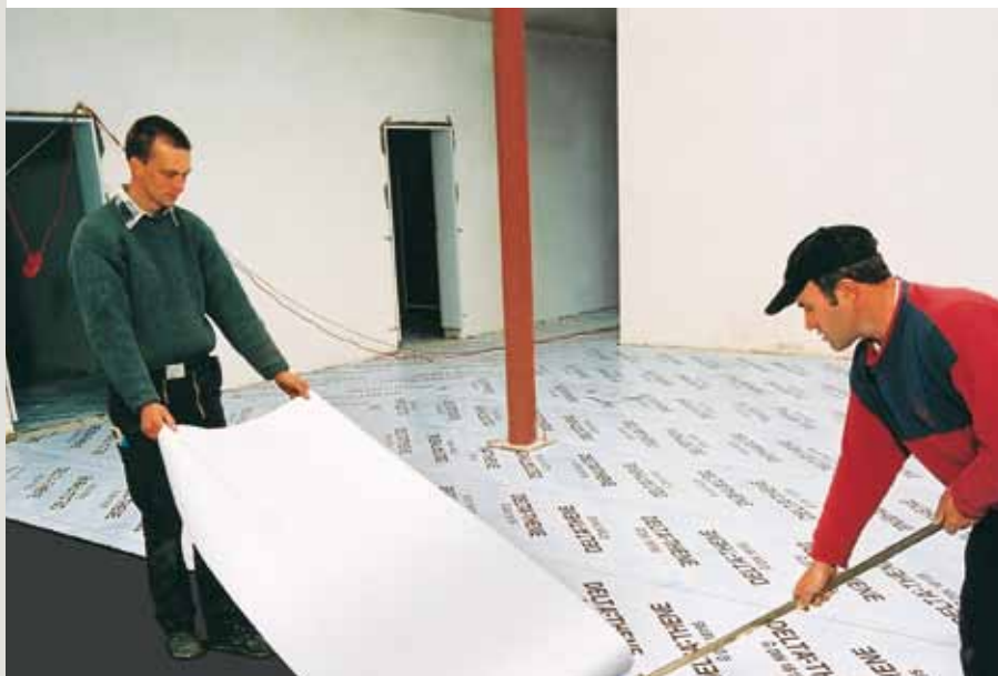
Гидроизоляция пола коттеджа мембраной DELTA®-THENE.
