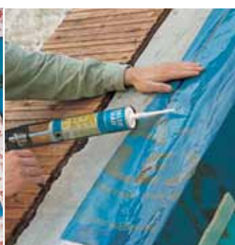
Пароизоляционная плёнка DELTA®-S d -FLEX для ремонта мансарды с внешней стороны.
