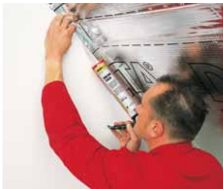
Примыкание к стене с клеем DELTA®-TIXX.
