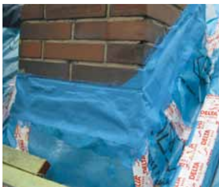
Примыкание к трубе с DELTA®-LIQUIXX.
