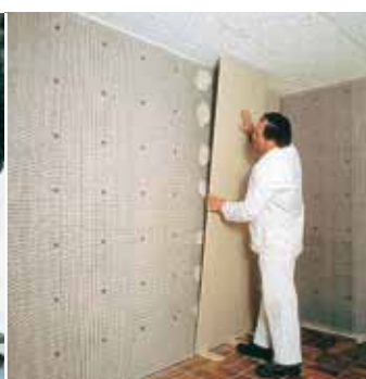
Специальная мембрана DELTA®-PT для ремонта влажных стен подвалов изнутри.
