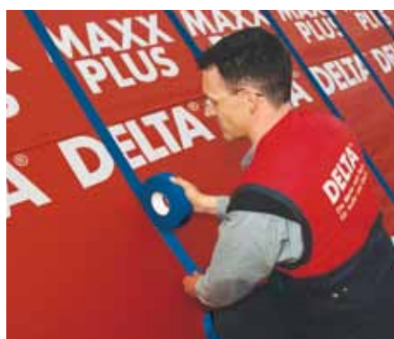
Уплотнение контробрешётки DELTA®-SB 60.
