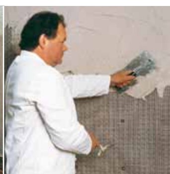
Специальная мембрана DELTA®-PT для ремонта влажных стен подвалов изнутри.
