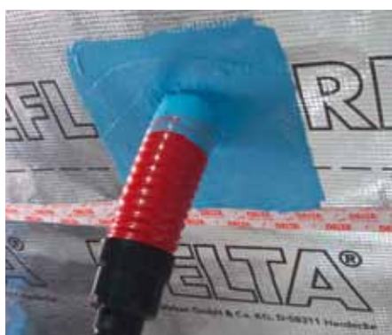
Уплотнение проходки пастой DELTA®-LIQUIXX.
