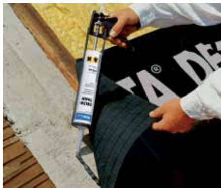
Проклейка на фронтоне клеем DELTA®-THAN.
