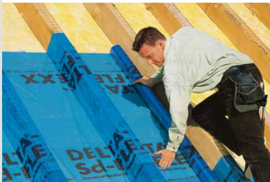
Пароизоляционная плёнка DELTA®-S d -FLEX для ремонта мансарды с внешней стороны.
