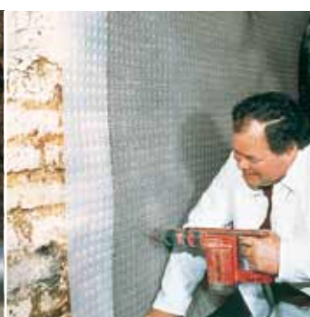
Специальная мембрана DELTA®-PT для ремонта влажных стен подвалов изнутри.
