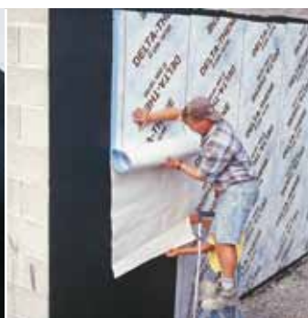
Гидроизоляция пола коттеджа мембраной DELTA®-THENE.
